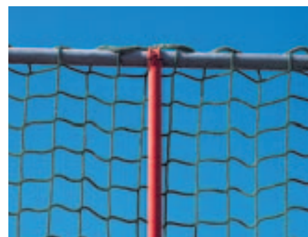
Beskyttelsesnettet tres ganske enkelt på et stillasrør.
