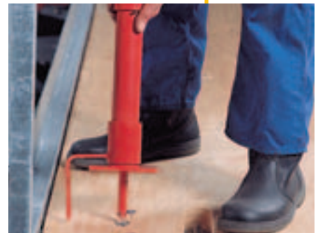
Endestolpene FBP for montering av rekkverkplankene fra byggesiden skrues til universalfestet (DW 15).
