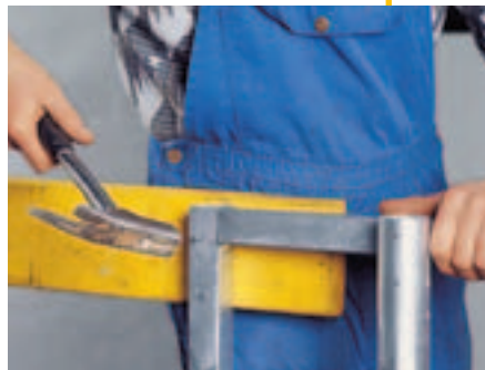
Spikerhull i rekkverkrammen for enkel festing av golvplank.
