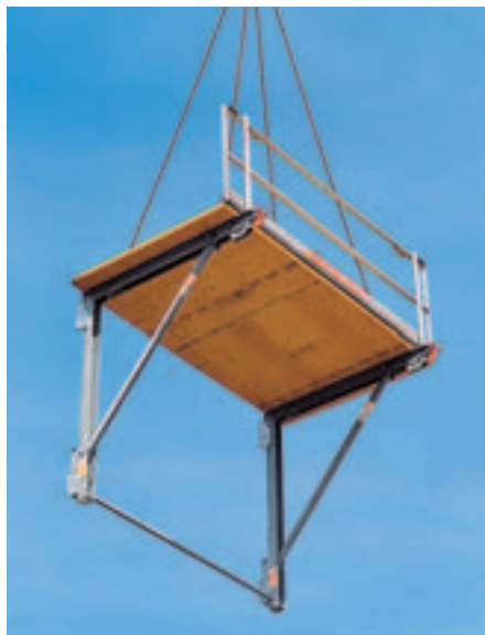
Heng firepartskev på de nedsenkbare kranfestene og løft opp plattformen.
