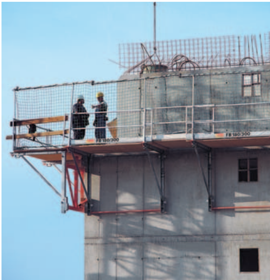
Foldeplattform FB 180-3 med beskyttelsesnett som taksikringsstillas.
