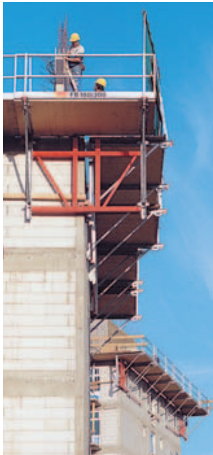
Bruk som hjørneplattform på høyre side.
