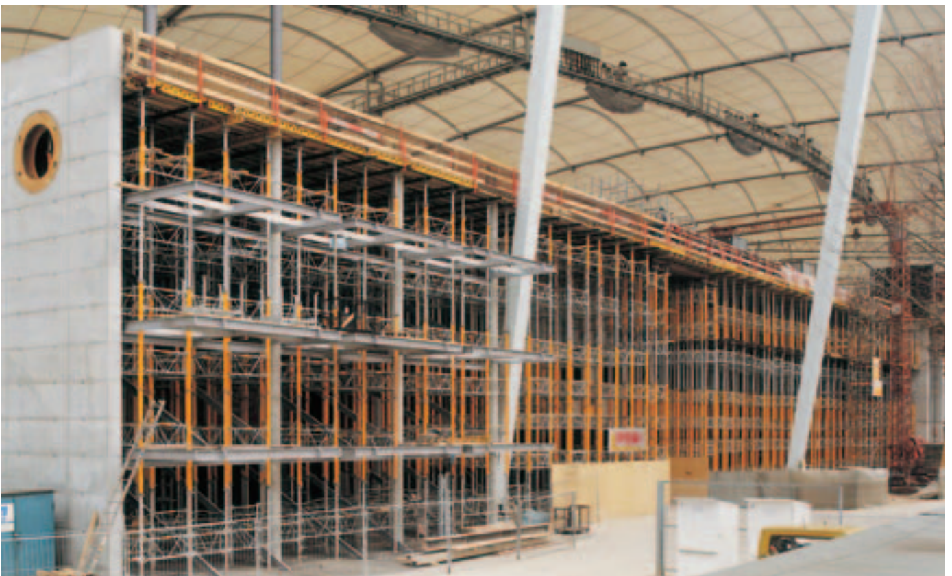
Sikker medtaging av store laster. 14,00m høy MULTIPROP understøttelse på en flate på 3500m 2
