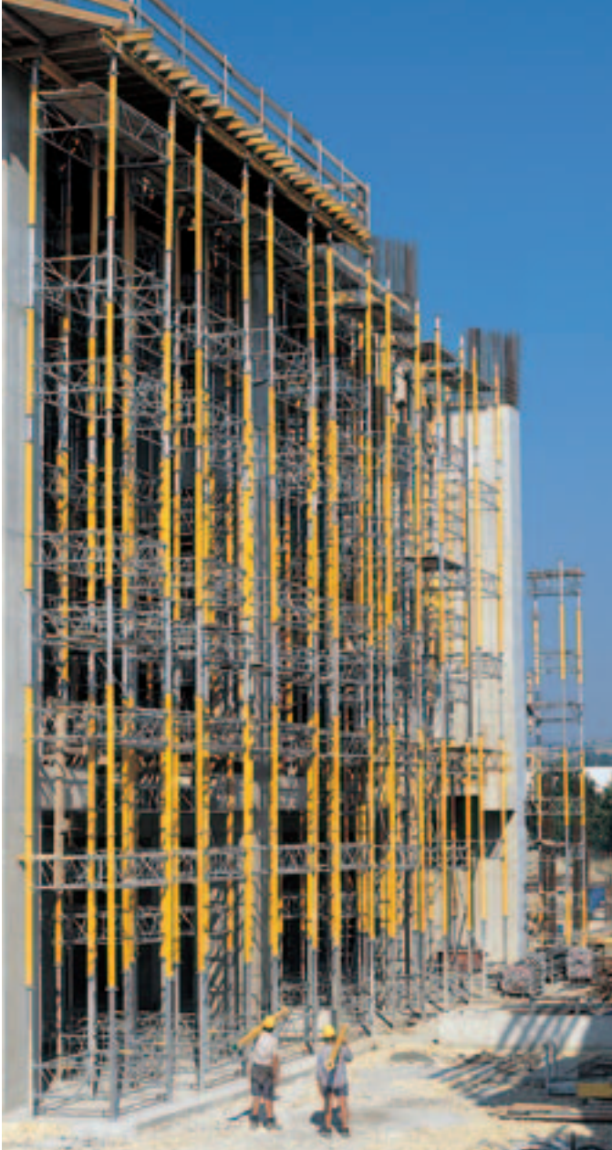
20m høyt MULTIPROP tårn som understøttelse for et utkraget dekke.
