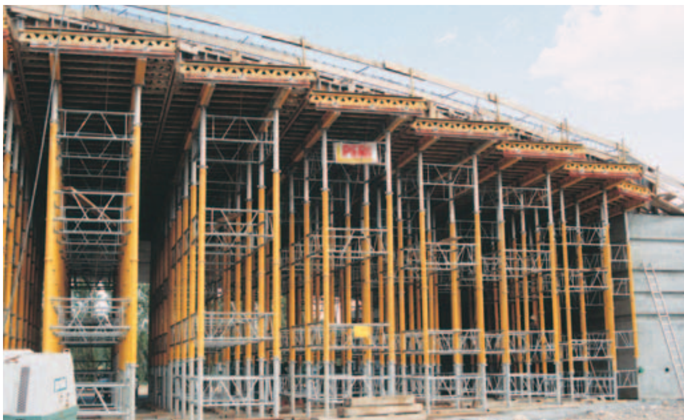
Forskalingsdekke for bro-overbygg med MULTIPROP og GT 24 dragere.
