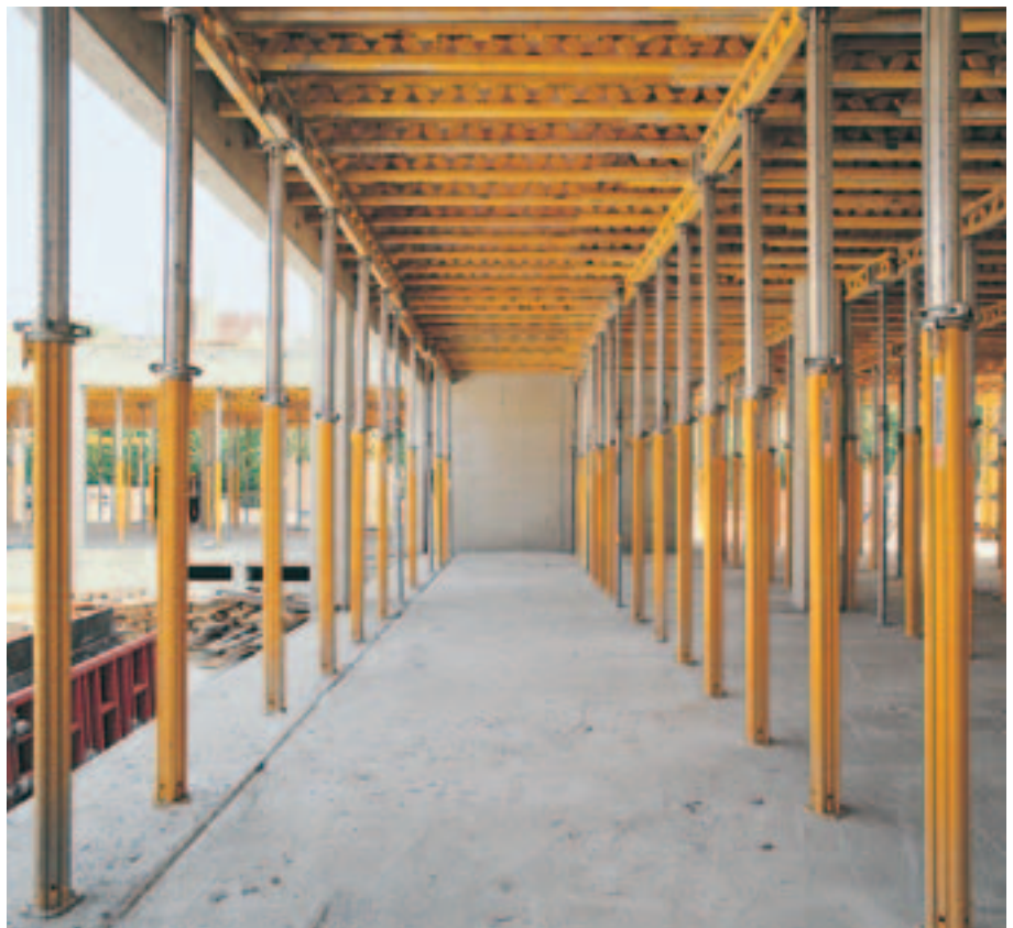
MULTIPROP 350 som MULTIFLEX dekkereis.
