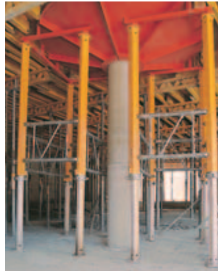
MULTIPROP 350 med rammer som understøttelse av en pilshodeforskaling.
