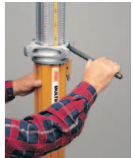
MULTIPROP's gjengespindel kan dreies ved hjelp av et stag.
