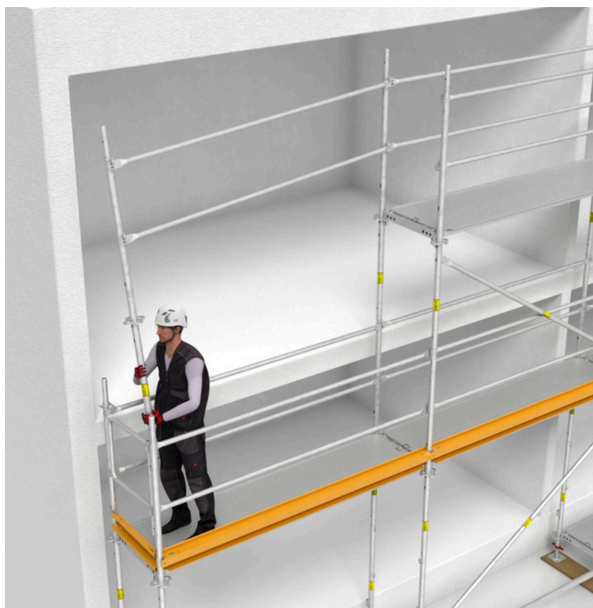
Rekkverk til neste nivå monteres fra nivået under, hvilket gjør at monteringen kan utføres uten bruk av eget sikringsutstyr.
