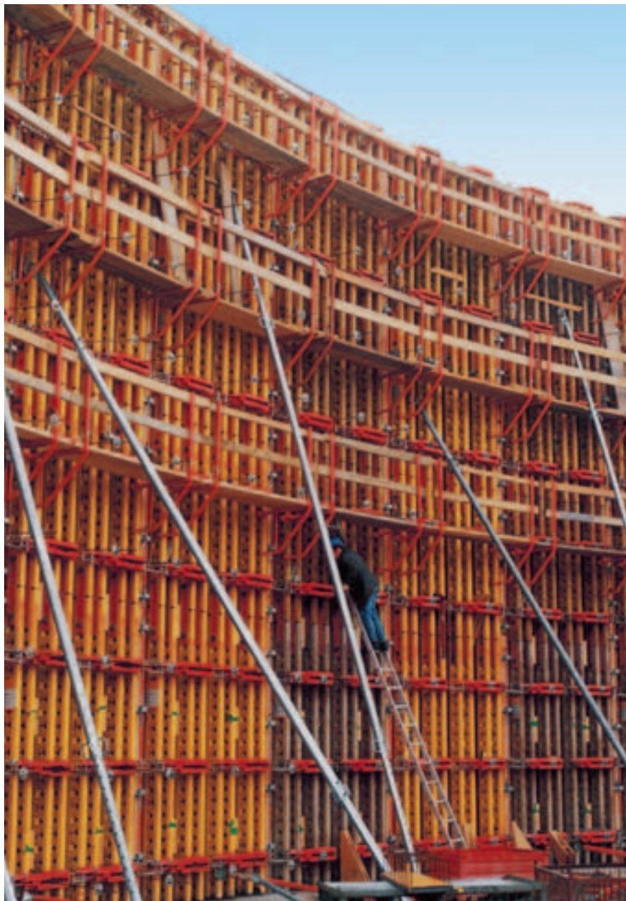
Del af renseanlæg, radius 1,10 m forskallet med RUNDFLEX-form A 85, I 72.
