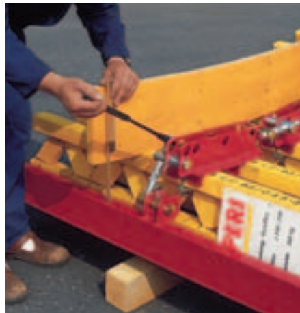
Kombi skraldenøglen bruges til vantskrue 210 til justering af kantprofil.
