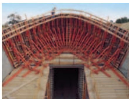
Ellipseformet tunnelportal med RUNDFLEX-forme og tilbehør fra VARIO programmet. De konstant varierende radier og hældningen blev løst med konisk skåret træ.
