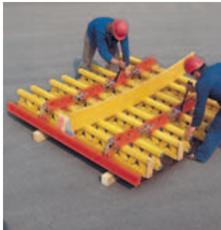
Kontrol af krumningen sker ved at placere radiusskabelonen på formdragerne.
