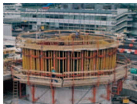
Inderkerne og brystning til en parkeringsrampe. Nem indstilling af radius med de selvrensende vantskruer.
