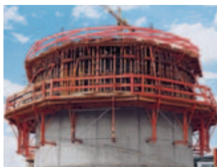
RUNDFLEX-forme på klatringssystem KG 180 til opførelsen af en rampe hos en bilforhandler.
