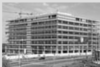
Arbeidsstillaser for fassade
