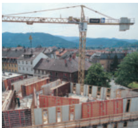
Elementenheter opp til 9 m brede og 2,70 m høye utstyrt med store strukturfinerplater
