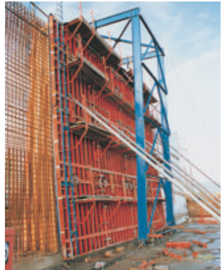
Komplett TRIO enhet 8,40 m høy. Oppstilling og lukking opphengt i portalkran.
