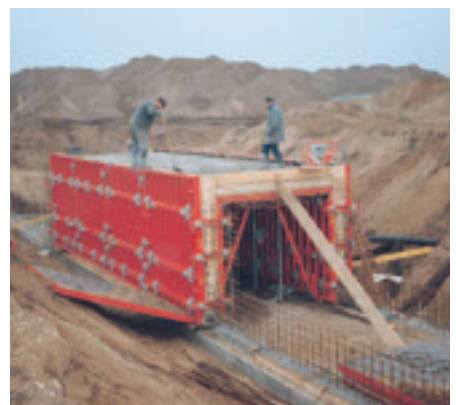
Rektangulær tunnel med standard TRIO deler.
