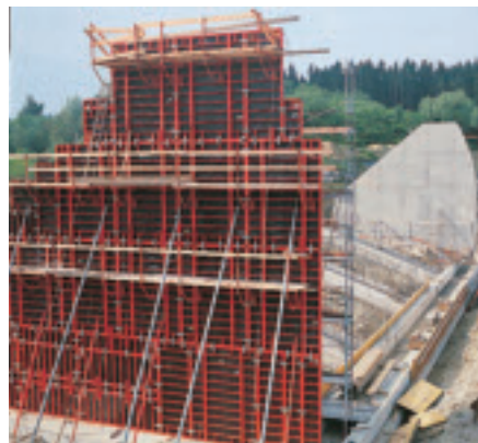
13,20 m høy vegg
