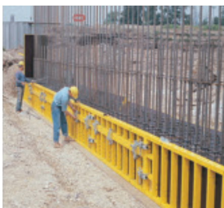
TRIO-L (alu) brukt til fundamenter.
