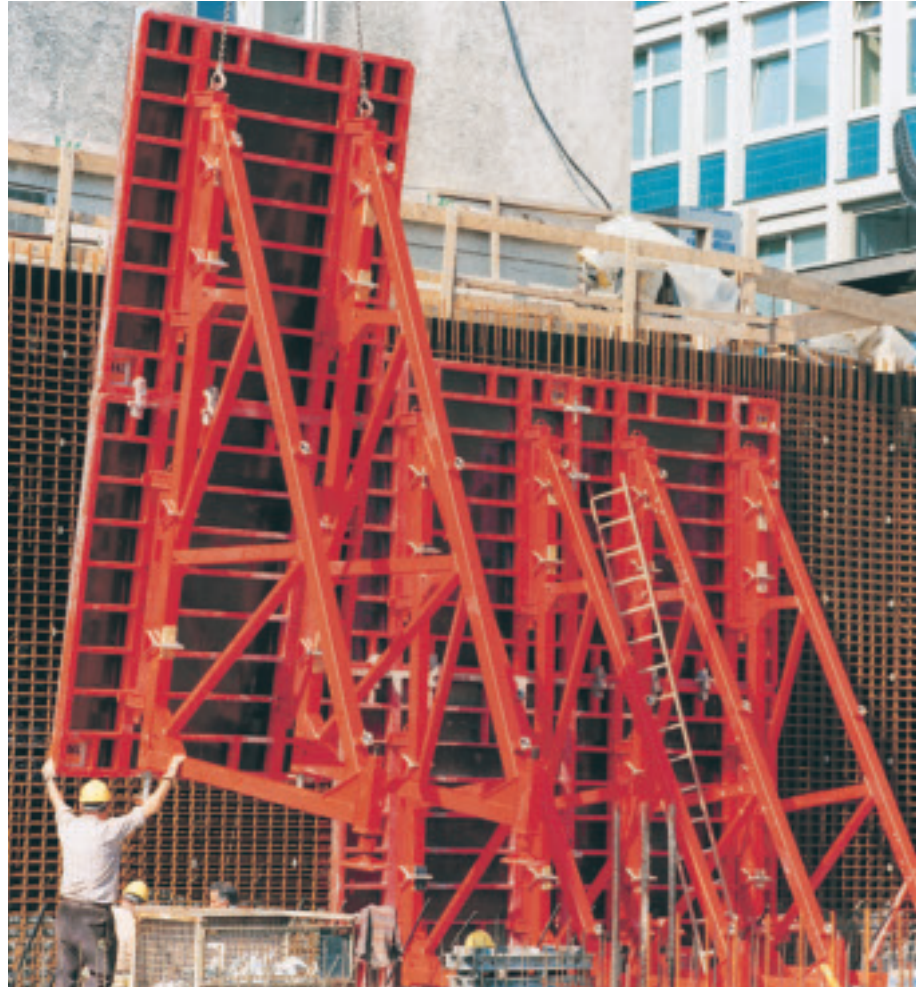
SB-2 støttebukk med TRIO 5,40 m høy.
