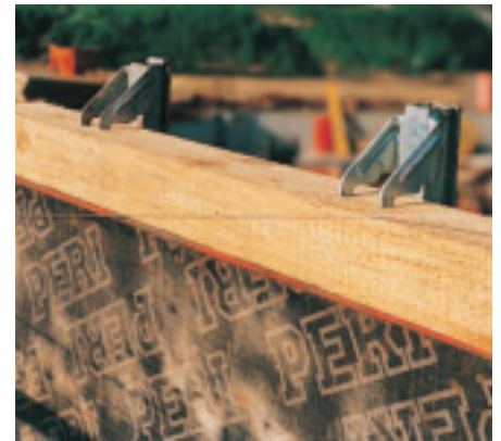
Oppskjøt med treverk
