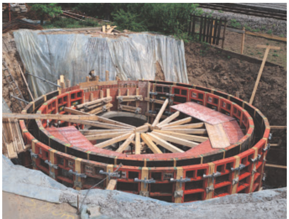
Avløpstank forskalet med TRIO TR 270 x 60 elementer.
