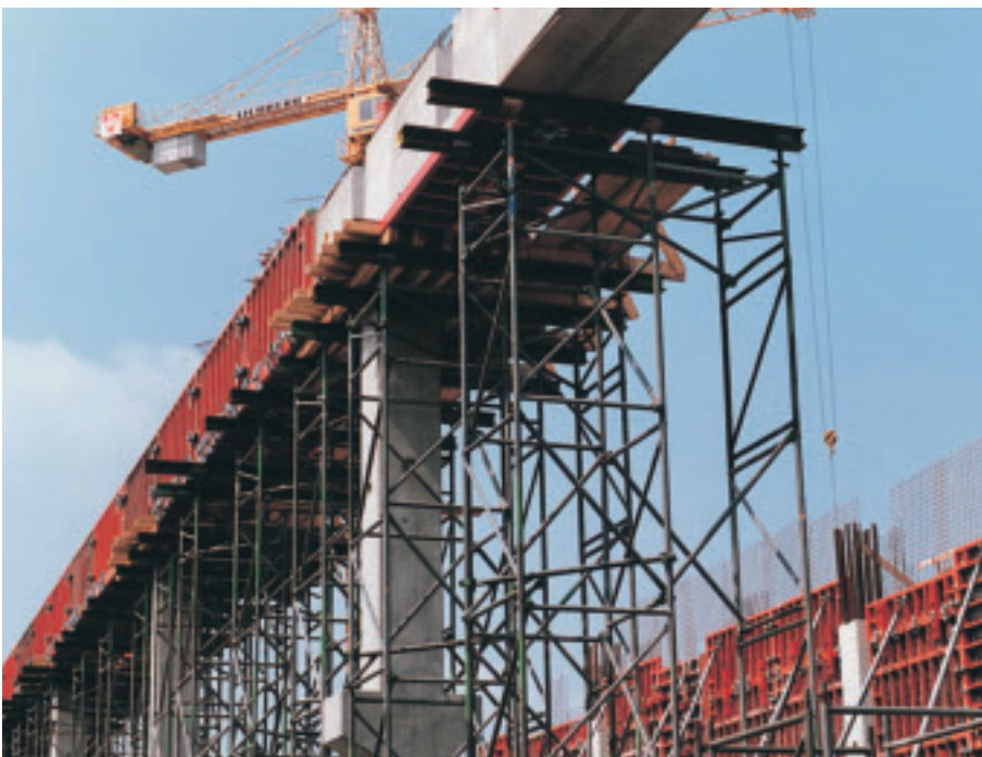
Store dragere med TRIO. Støttet opp av tårn
