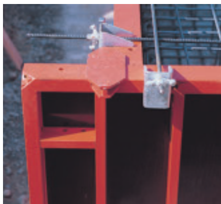
TRIO fundamentfeste og festebrakett virker i kombinasjon for store fundamenter.
