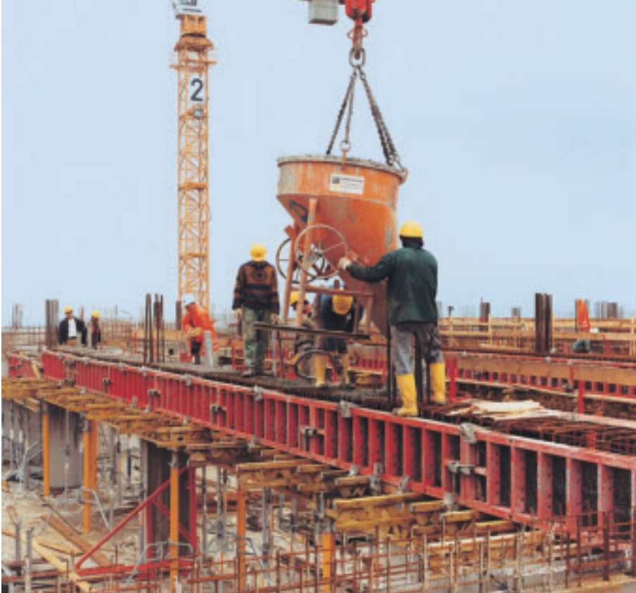
Mindre dragere med TRIO. Støttet opp av MULTIPROP.
