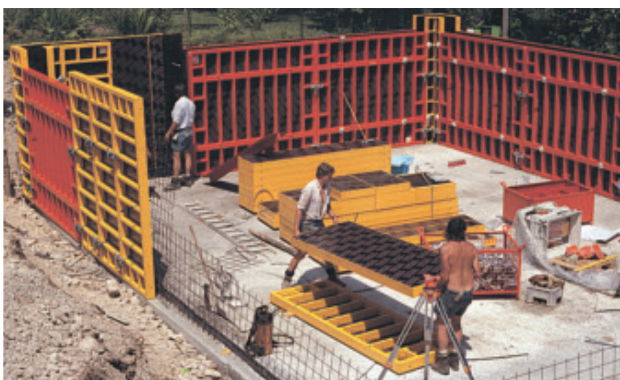
En byggeplass med TRIO-L (alu) og TRIO stål. Hjørnene og utfyllingene er forskalet med TRIO-L (alu) for hånd, og det er bare nødvendig å bruke kranen for de store stålelementene (270 x 240).
