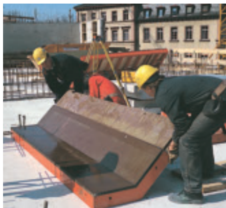
135° hjørnepanel utstyrt med store forskalingsbeleggplater brukt ved byggingen av et hotell.
