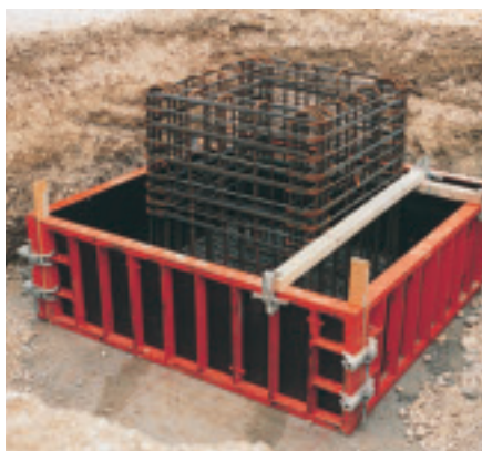
Elementer som brukes liggende for fundamenter
