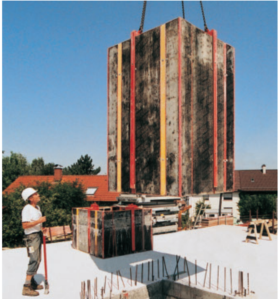
Komplett sjaktforskaling hengende i kranen.
