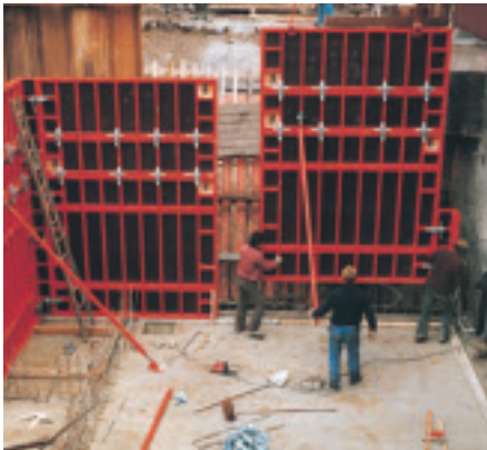
Oppskjøt med liggende standard elementer.
