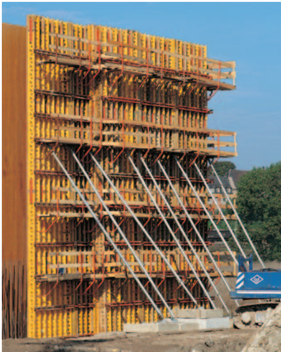
10,70 m høye vegger med to ganger oppskjøtet VARIO forskaling.
