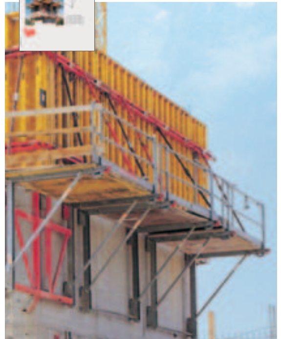
VARIO standardelementer på foldeplattform FB 180 i et boligbygg.
