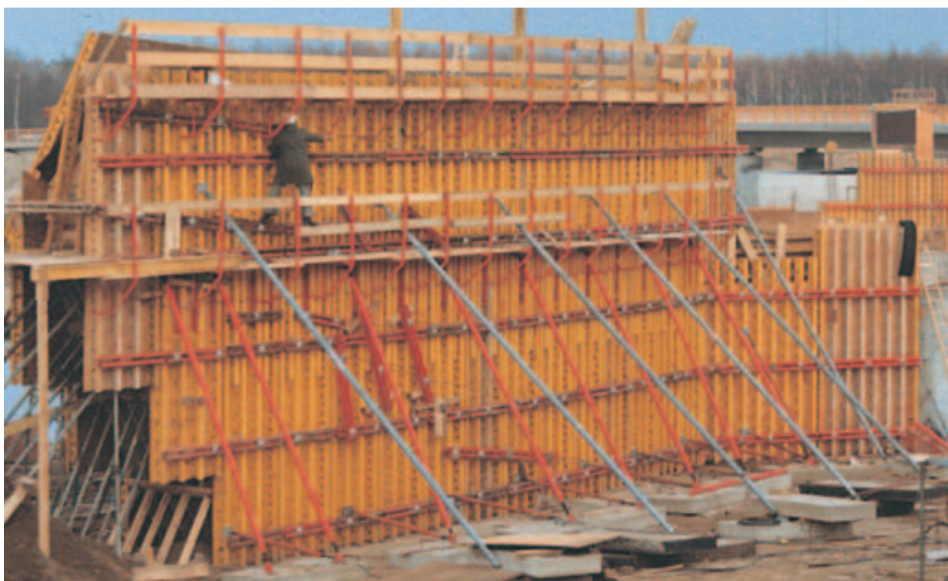
Komplisert landkar med VARIO GT 24. Enkel tilpasning med drager GT 24 og stålprofil.
