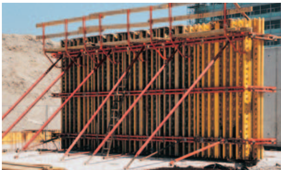
4,20 m høy VARIO med påmontert endesteng.
