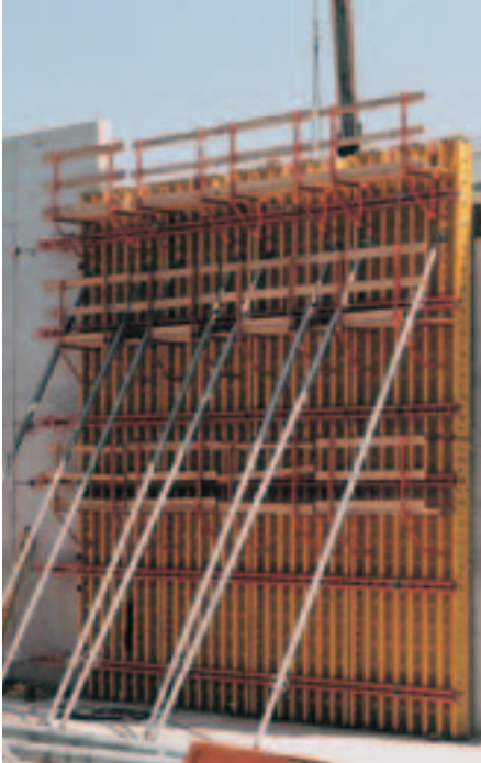
Oppskjøtede VARIO elementer i et administrasjonsbygg (se avsnitt Elementoppkjøt på side 26).
