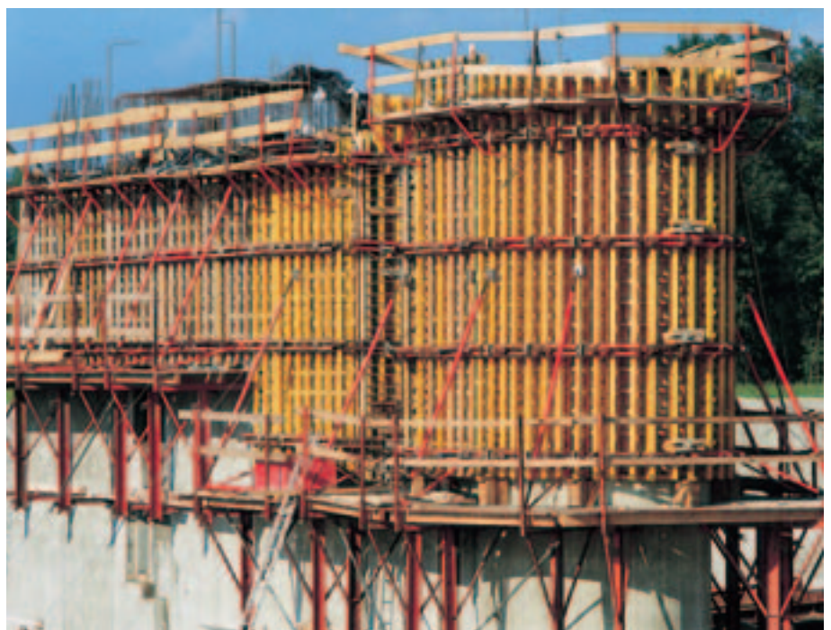
Front av moloen. VARIO i forbindelse med rundforskalingssystem GRV på klatrestillas KGF 240.
