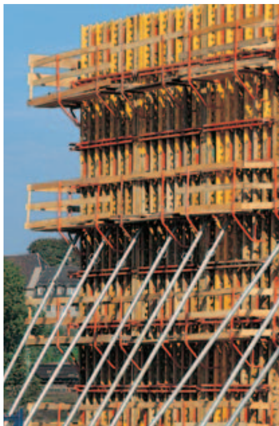
Bruksklare VARIO elementer: Komplet med skråstøtter, utliggere og støpeplattform.
