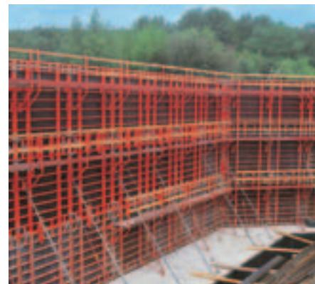
TRIO ved industribygg
