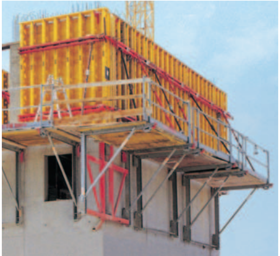
VARIO standardelementer med foldeplattform FB 180 ved et boligbygg.
