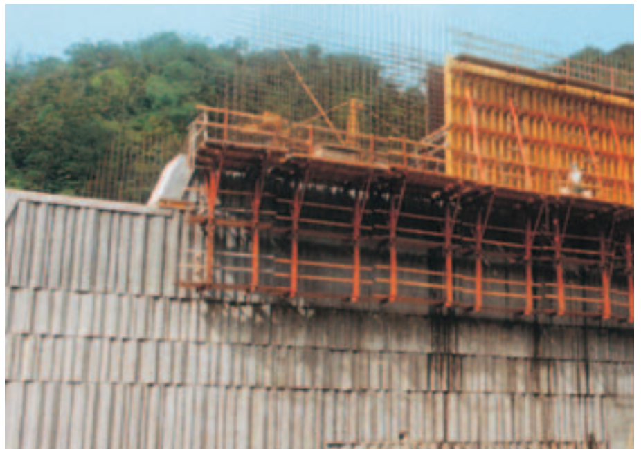
Tunnelåpning på Hawaii. Forskalet med VARIO GT 24 på klatrekonsoll KGF 240.
