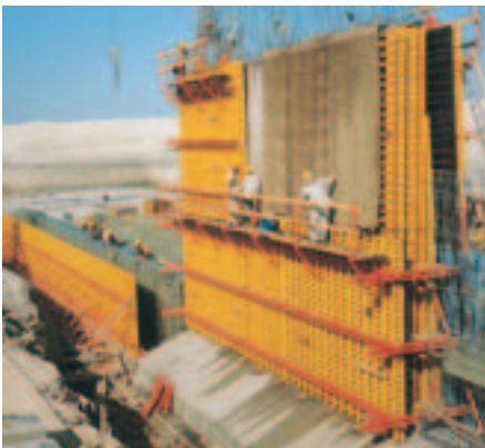
VARIO GT 24 i bruk ved bygging av et rensanlegg med konisk formede vegger i Korea.
