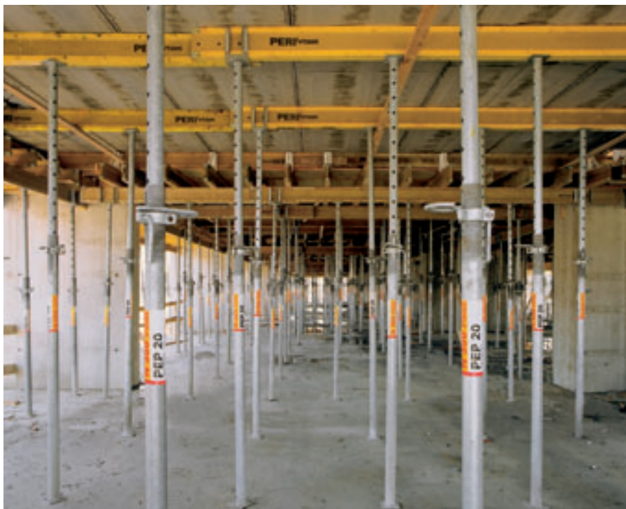
PERI drager VT 20 og PEP dekkstøtter til understøttelse av plattendecker
