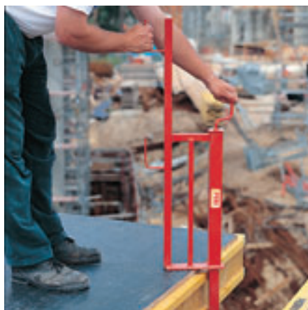
PERI rekkverksholderen skrues bare fast.
