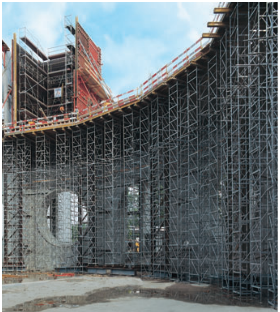
MULTIPROP 350 med MULTIFLEX dekkforsking.
