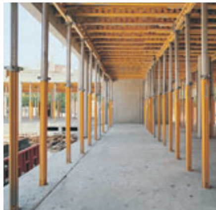
MULTIPROP 350 med MULTIFLEX dekkforsking.
