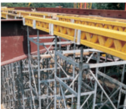
Toppaffelspindel ST 100 holder to stk GT 24 og sikrer dem mot å vippe.
