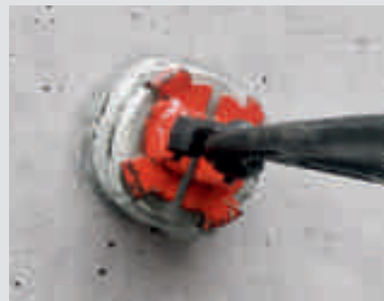
Sett betongkonusen inn i avtrykket, og dri lett flere ganger for å sikre at limet fordeler seg jevnt.
