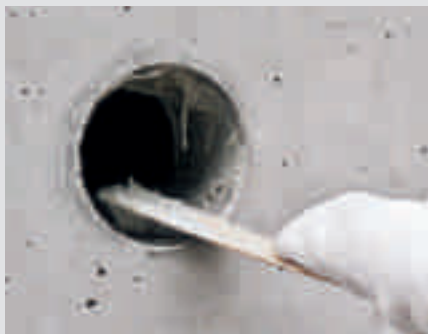
Dekk det rengjorte hullet sparsomt med tetningslim
