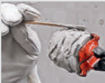
Hold konusen med konustangen og smør overflaten og enden jevnt med tetningslim.
