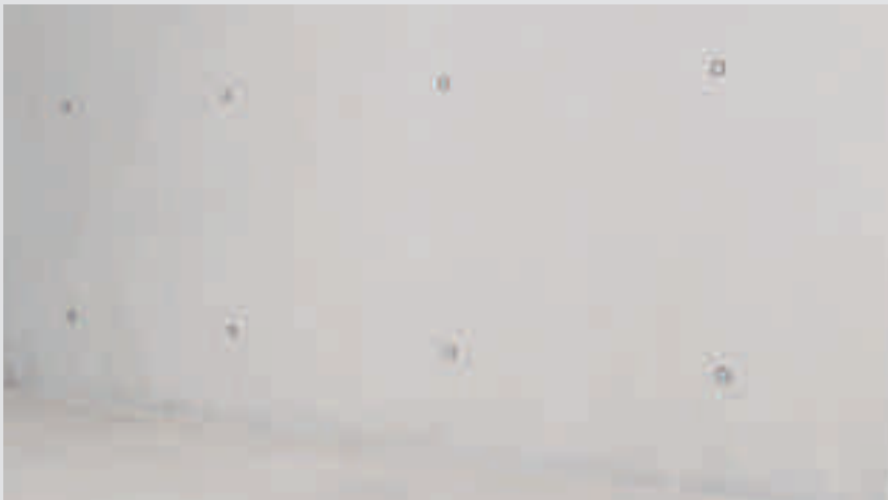
Betongkonus med skyggekonus limt på plass
