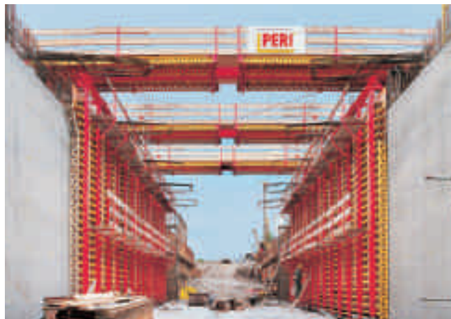
Omkjøringstunnel B311 Ertingen, Tyskland.
